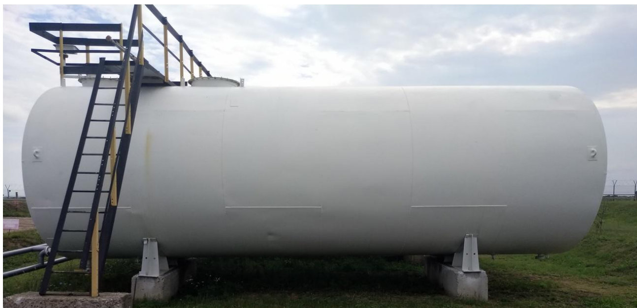
Рисунок 1 – Общий вид резервуара стального горизонтального цилиндрического РГС-50
