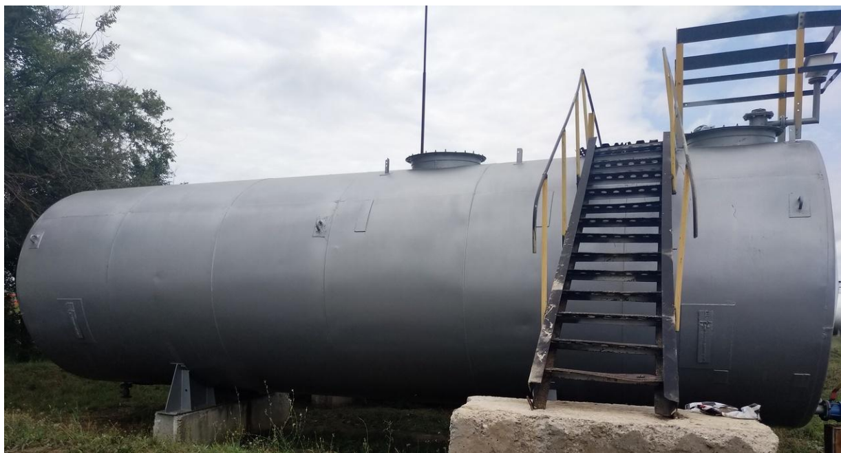
Рисунок 2 – Общий вид резервуара стального горизонтального цилиндрического РГС-75
