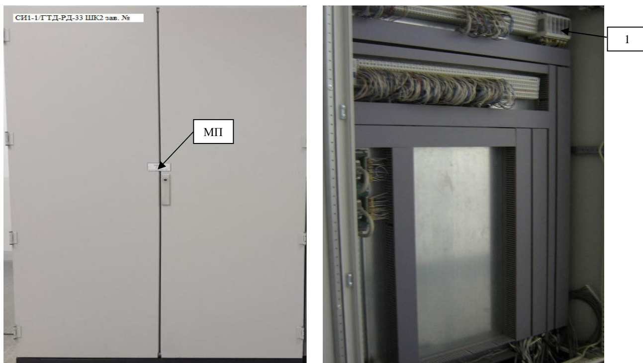
а) – внешний вид б) – внутреннее устройство 1 – преобразователи сигналов НПСИ-ДНТВ Рисунок 6 – Шкаф ШК2
