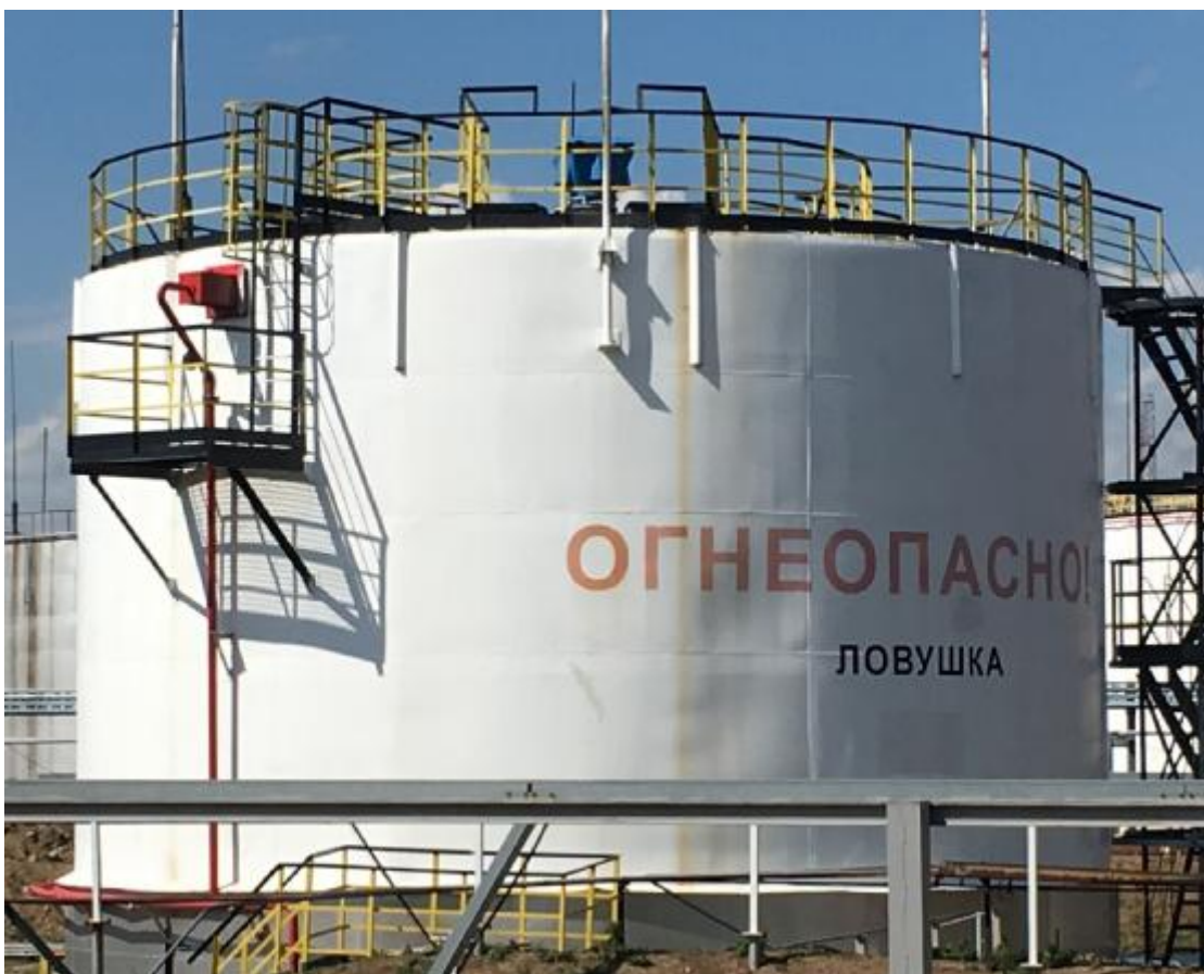
Рисунок 1 – Общий вид резервуара стального вертикального цилиндрического РВС-1000
