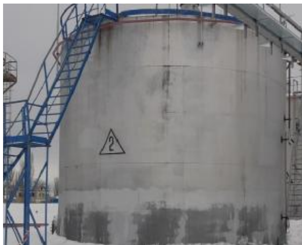
Рисунок 1 – Общий вид резервуара стального вертикального цилиндрического РВС-400, РВСП-400
