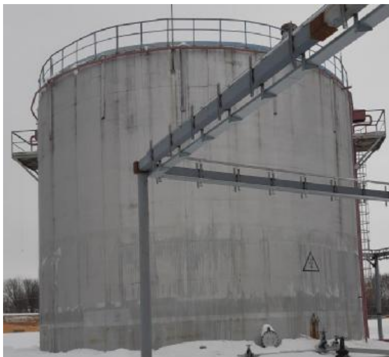
Рисунок 4 – Общий вид резервуара стального вертикального цилиндрического РВСП-2000
