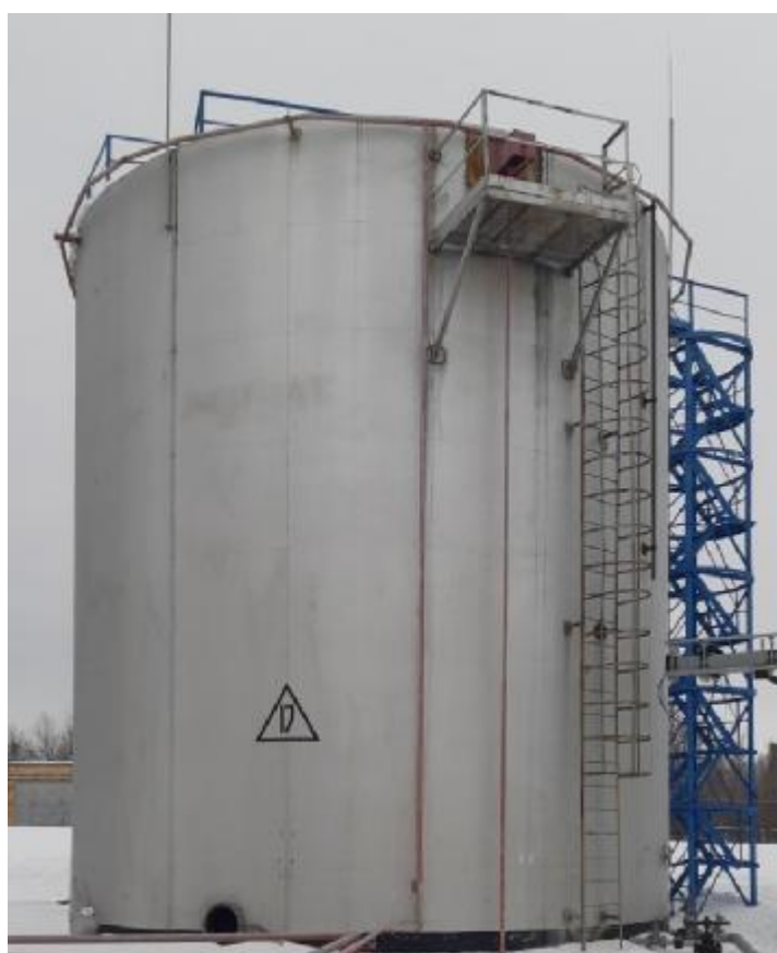
Рисунок 3 – Общий вид резервуара стального вертикального цилиндрического РВС-1000, РВСП-1000
