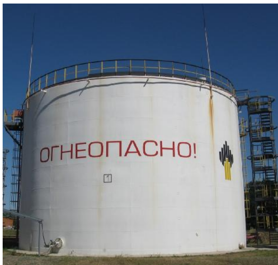
Рисунок 5 – Общий вид резервуара стального вертикального цилиндрического РВС-3000, РВСП-3000
