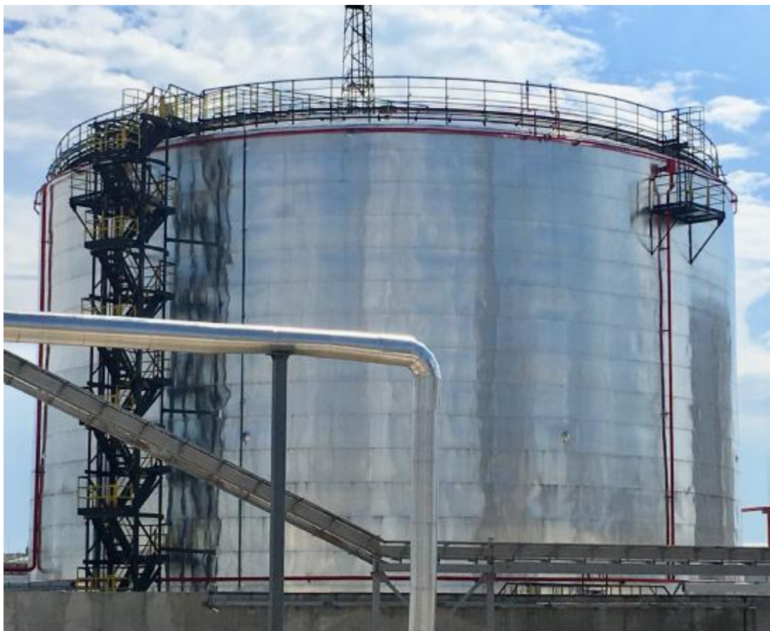
Рисунок 1 – Общий вид резервуара стального вертикального цилиндрического РВС-10000
