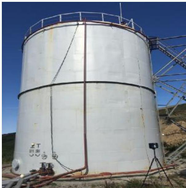
Рисунок 2 – Общий вид резервуара РВС-1000 заводской № 5
