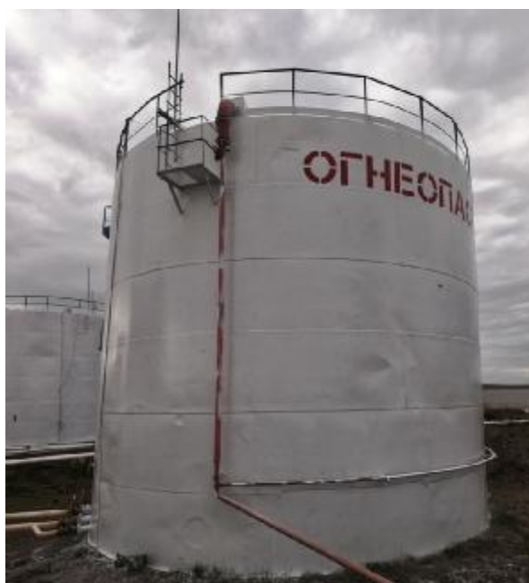
Рисунок 1 – Общий вид резервуаров РВС-700
