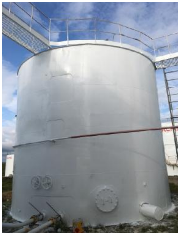
Рисунок 2 – Общий вид резервуаров РВС-200
