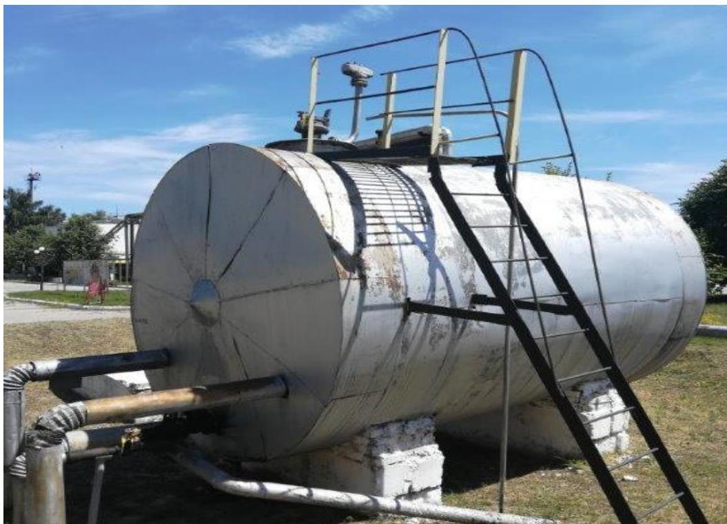
Рисунок 1 – Общий вид резервуара стального горизонтального цилиндрического РГС-25
