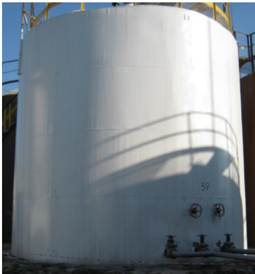
Рисунок 1 – Общий вид резервуара стального вертикального цилиндрического РВС-200
