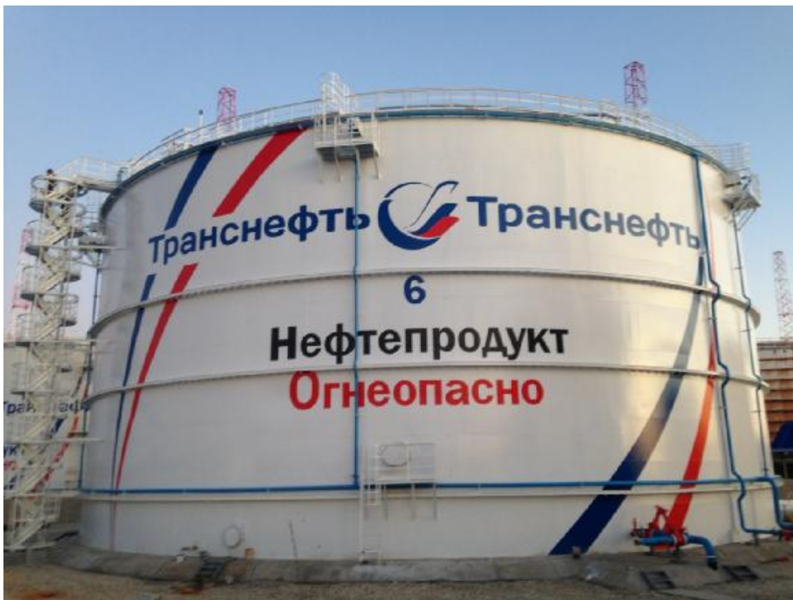
Рисунок 1 – Общий вид резервуара стального вертикального цилиндрического РВСП-20000
