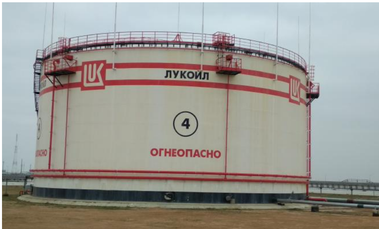
Рисунок 1 – Общий вид резервуаров РВСП-20000
