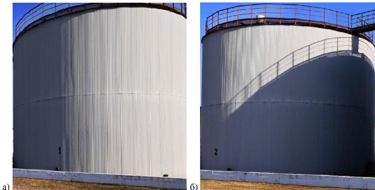
Рисунок 1 – Общий вид резервуаров стальных вертикальных цилиндрических РВС-2000 а) заводской номер 30.1, б) заводской номер 30.2
