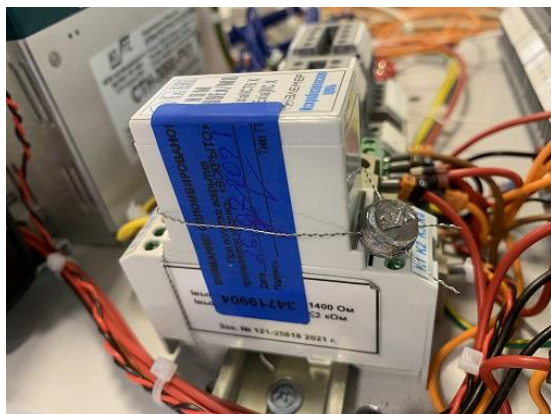
Рисунок 9 – Пломбирование преобразователя измерительного модульного ИПМ 0399
