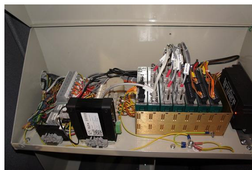
Рисунок 4 – БСК-01 без защитной крышки
