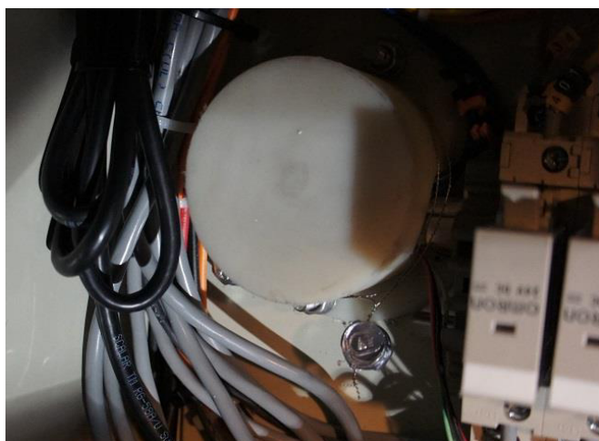
Рисунок 11 –Пломбирование преобразователей температуры PR, ПСТ, ИП 0304/МЗ-Н
