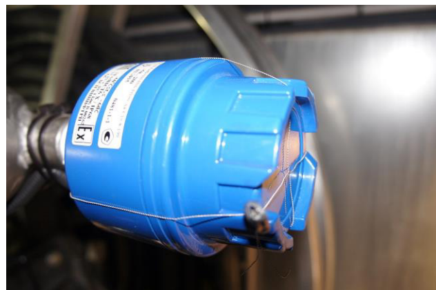
Рисунок 10 – Пломбирование датчика температуры
