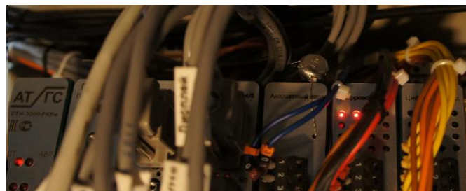
Рисунок 8 – Пломбирование платы аналогового входа контроллера
