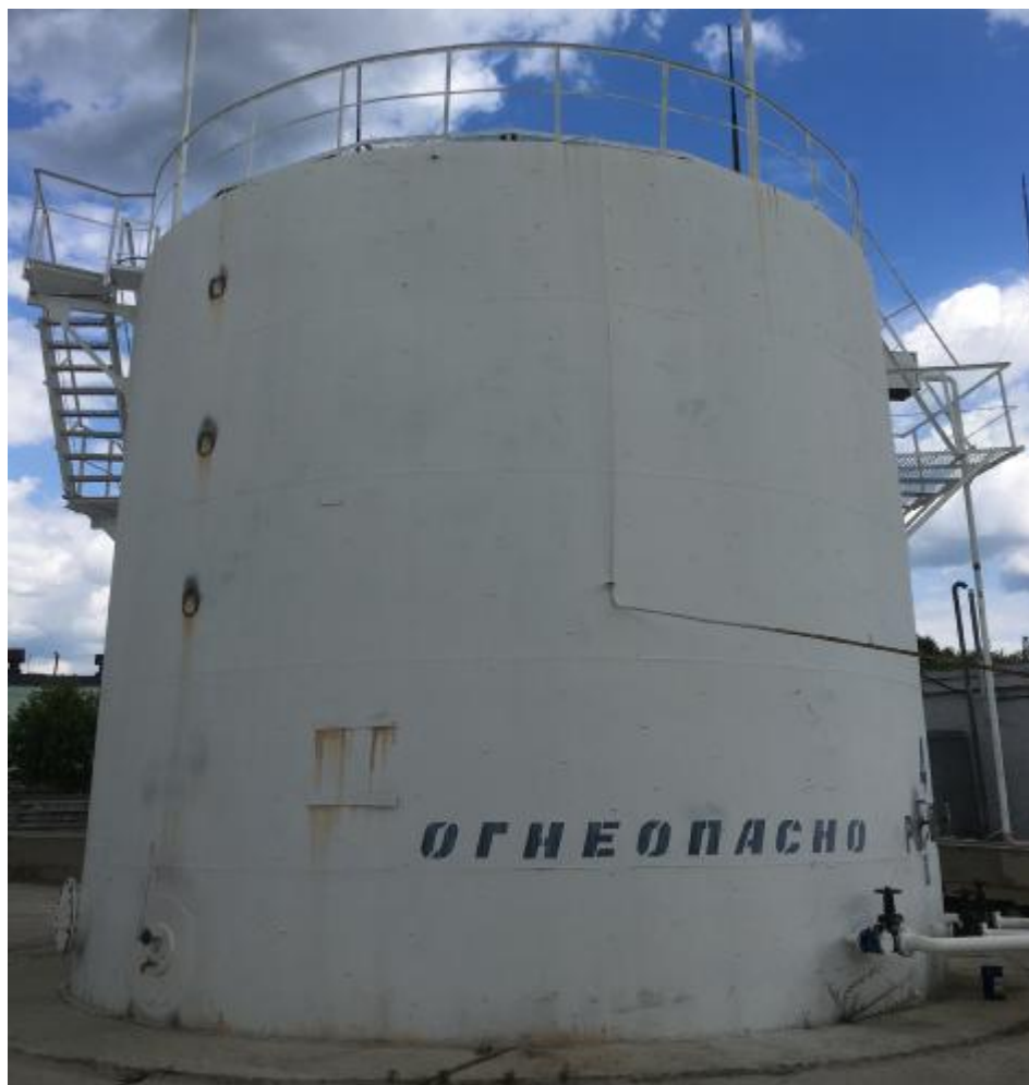
Рисунок 1 – Общий вид резервуаров стальных вертикальных цилиндрических РВС-400
