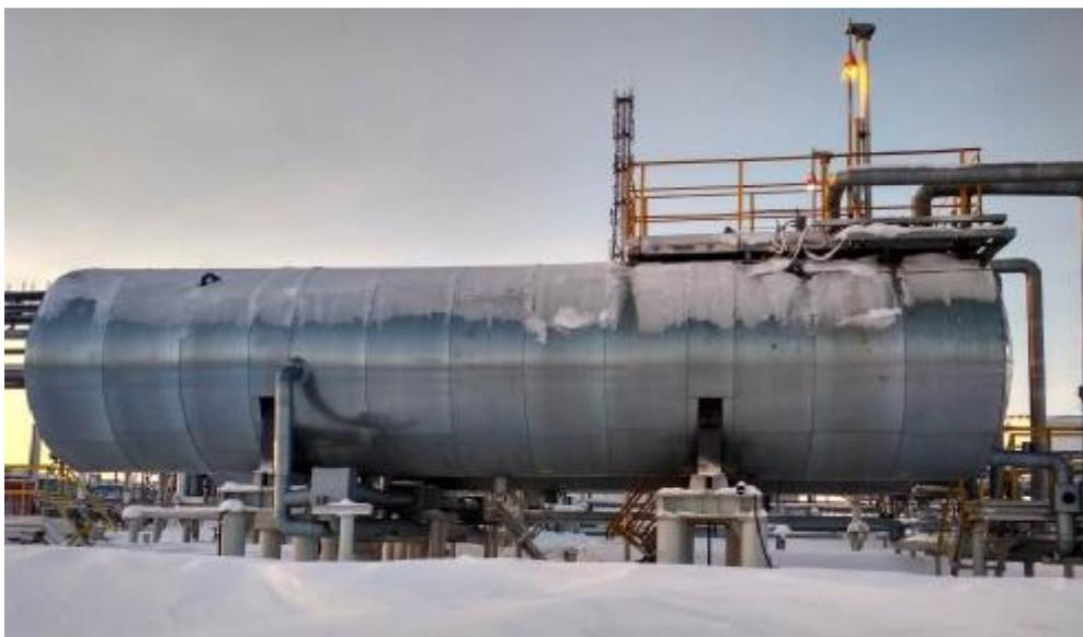
Рисунок 1 – Общий вид резервуара стального горизонтального цилиндрического РГС-100
