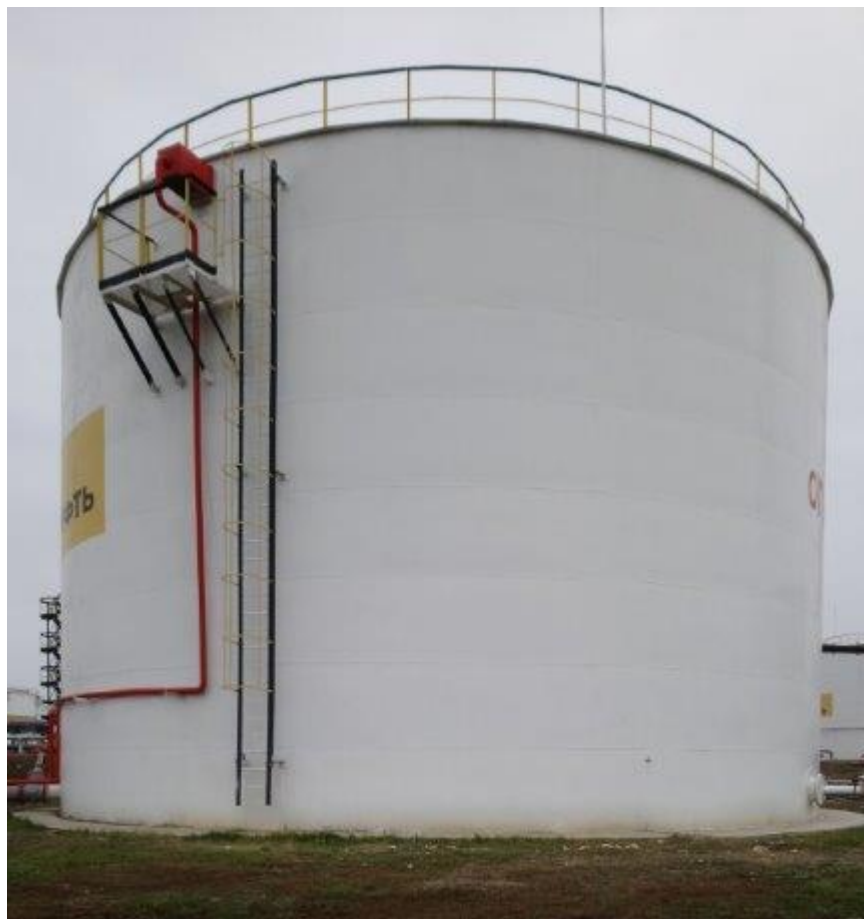
Рисунок 1 – Общий вид резервуара стального вертикального цилиндрического РВС-3000
