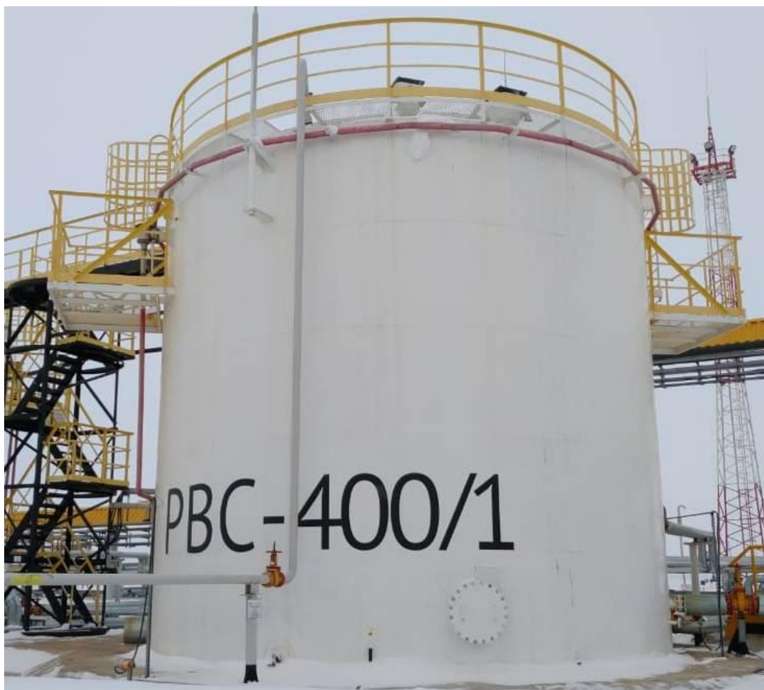
Рисунок 1 – Резервуар вертикальный стальной цилиндрический РВС-400
