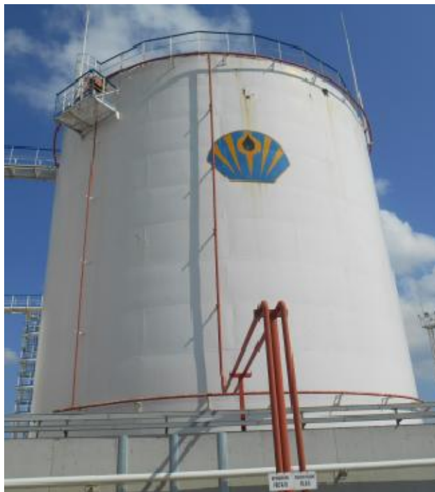
Рисунок 1 – Общий вид резервуаров стальных вертикальных цилиндрических РВС-3200 зав. №№ 15, 16, 17, 18
