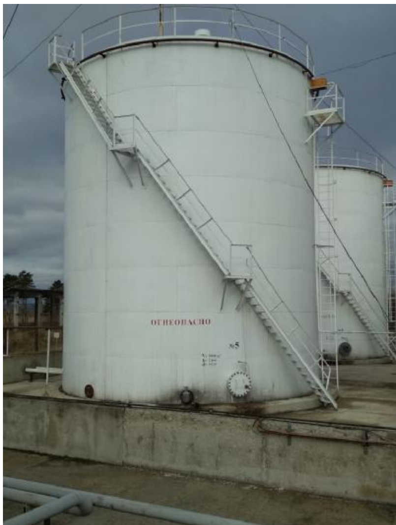
Рисунок 2 – Общий вид резервуара РВС-1000
