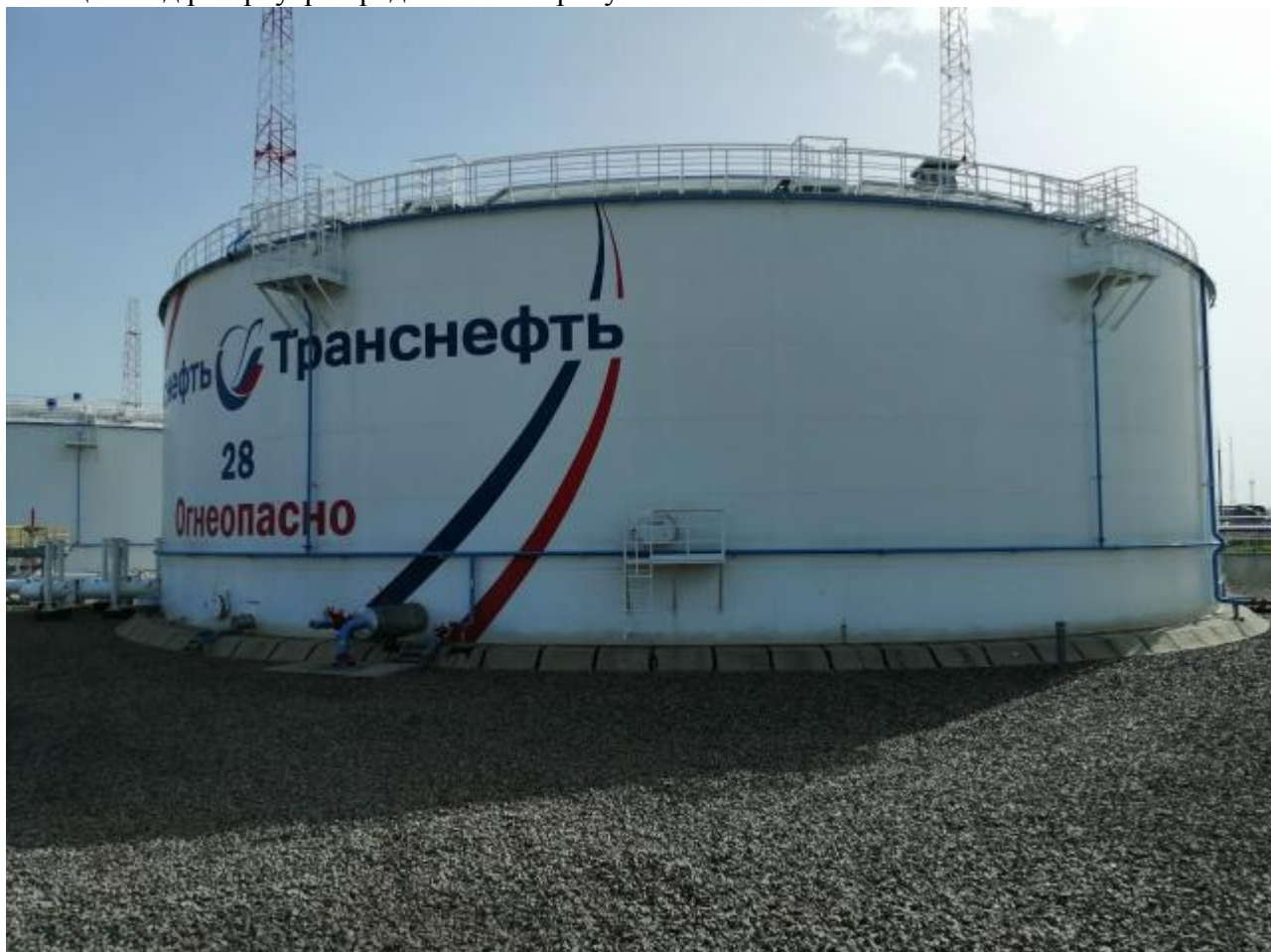
Рисунок 1 - Общий вид резервуара
