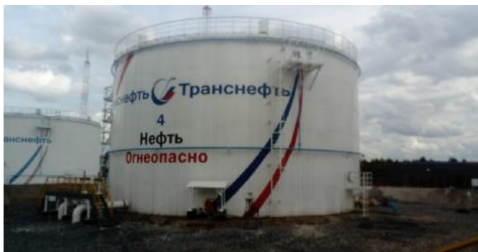
Рисунок 2 – Общий вид резервуара РВСП-5000 зав.№ 4
