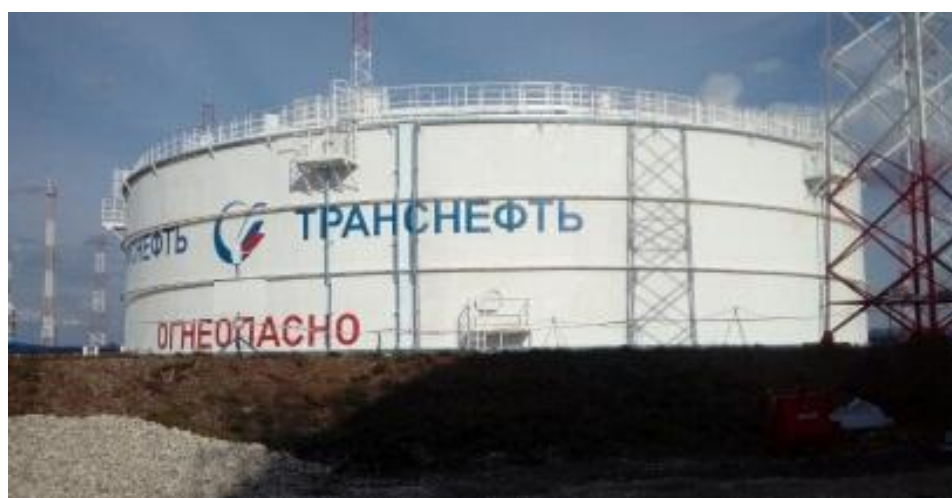
Рисунок 3 - Общий вид резервуаров РВСП-20000 зав.№№ 10, 12, 18
