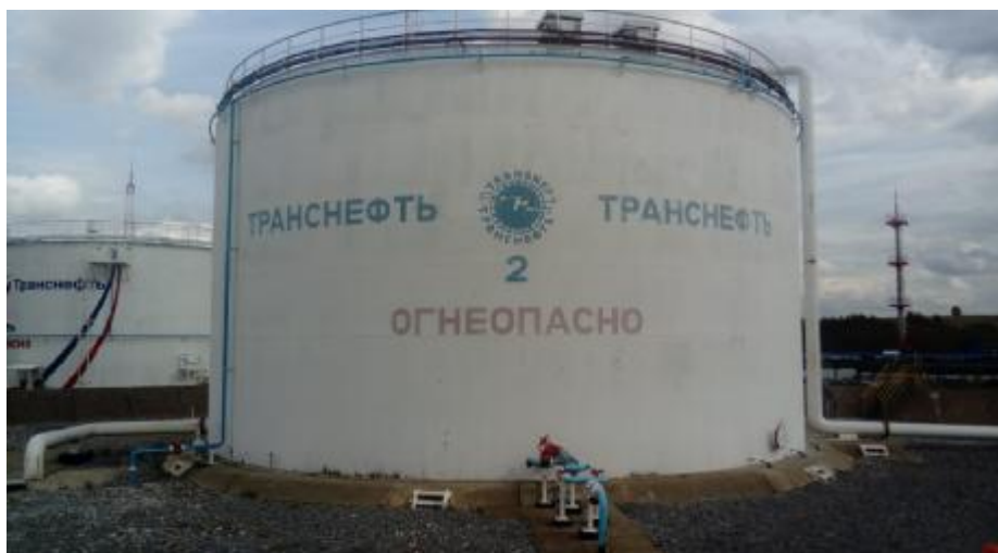
Рисунок 1 – Общий вид резервуара РВС-5000 зав.№ 2
