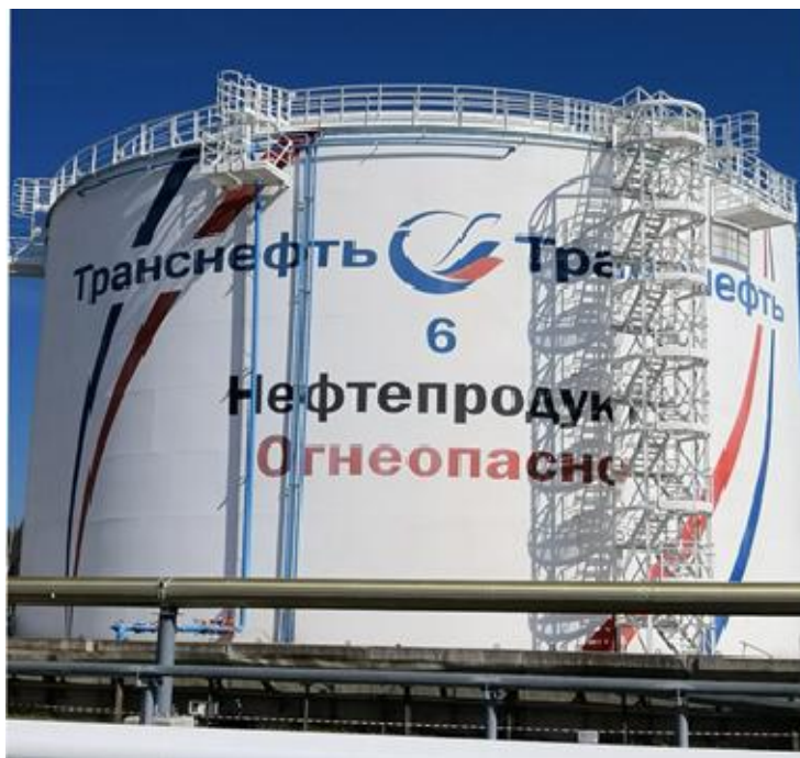
Рисунок 1 – Общий вид резервуаров РВС-10000 зав.№№ 4, 5, 6, 8
