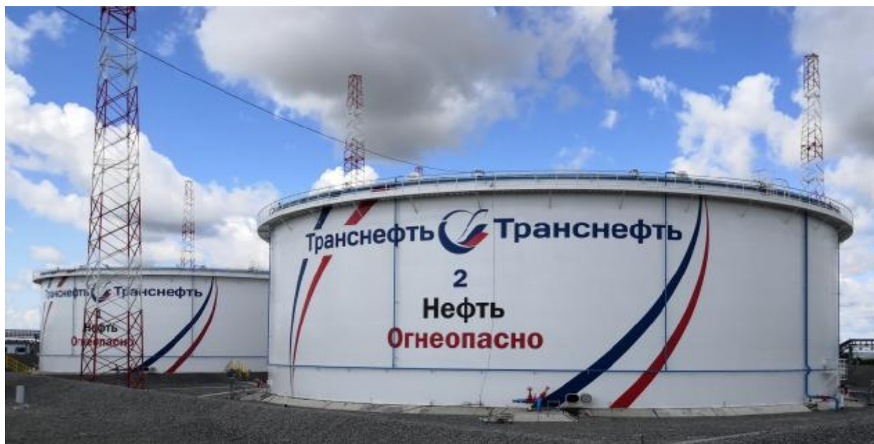
Рисунок 1 – Общий вид резервуаров РВСПК-50000 зав.№№ 1, 2
