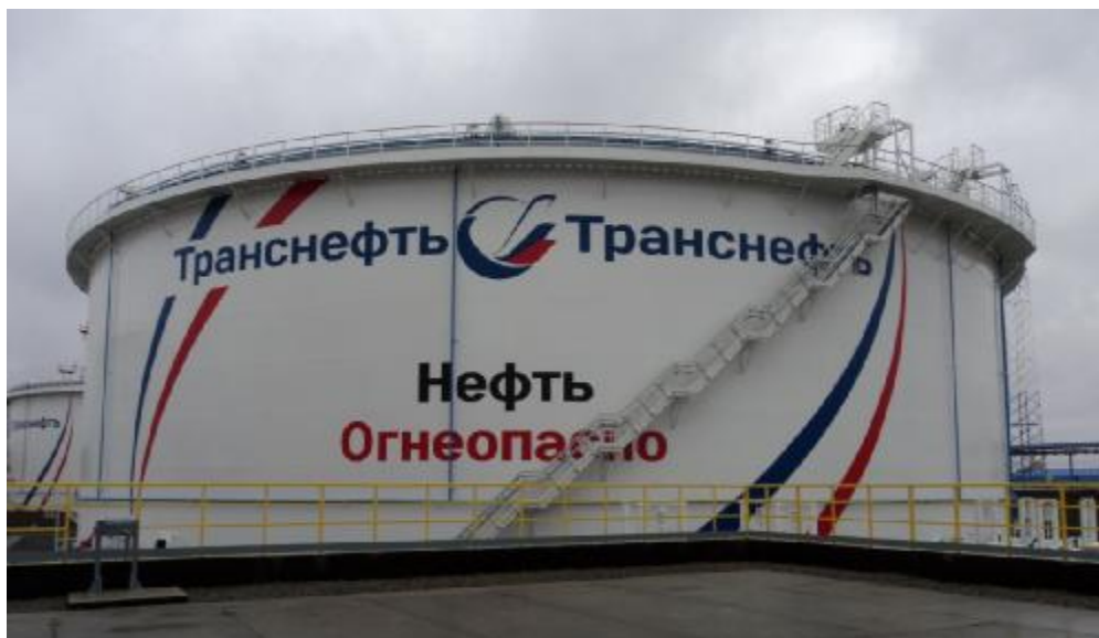
Рисунок 1 – Общий вид резервуаров РВСПК-50000 зав.№№ 4, 6, 7
