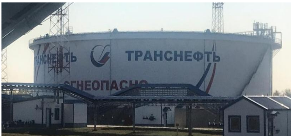
Рисунок 1 – Общий вид резервуаров РВСПК-50000 зав.№№ 21, 22
