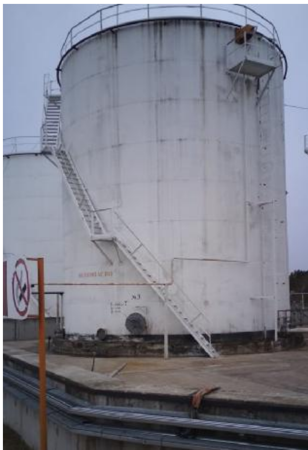
Рисунок 1 – Общий вид резервуара РВСП-1000
