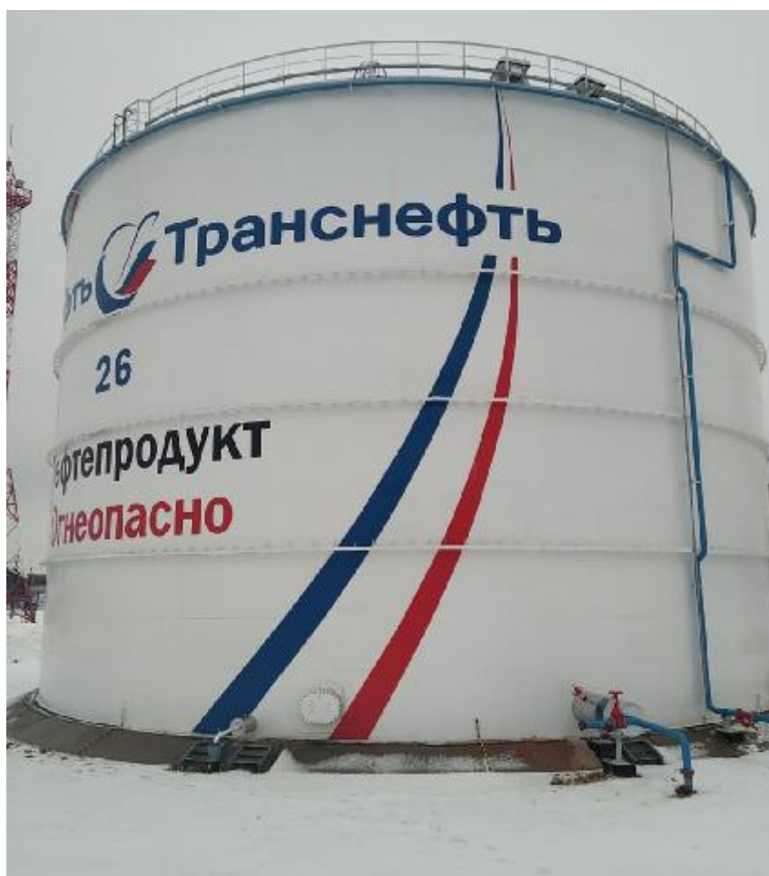
Рисунок 2 – Общий вид резервуара РВС-10000 № 26
