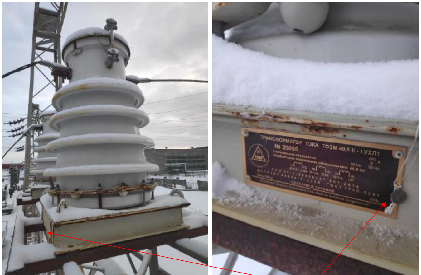
Рисунок 1 - Общий вид средства измерений и обозначение места пломбировки от несанкционированного доступа (А)
