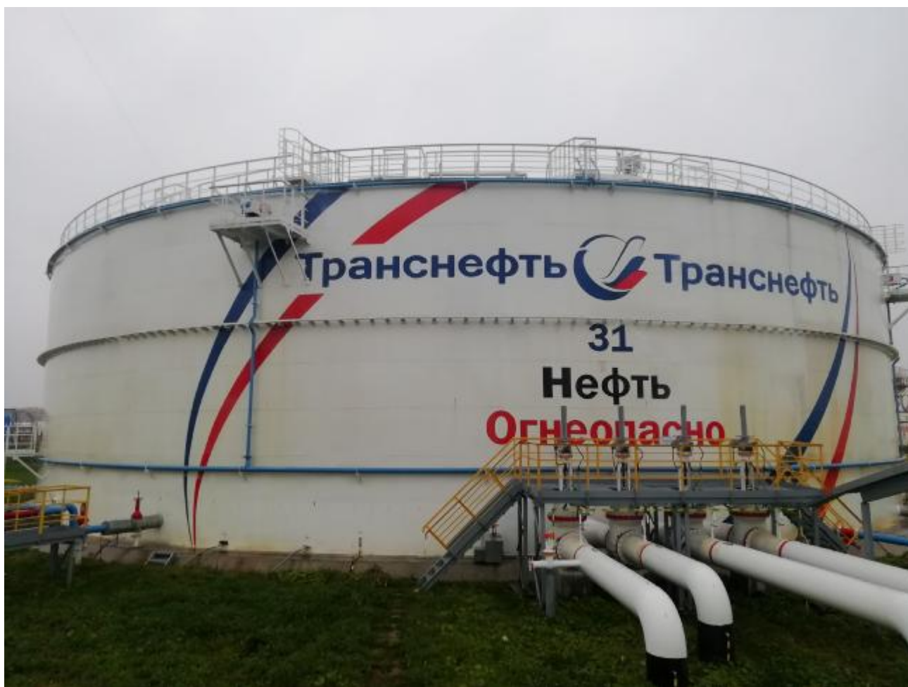
Рисунок 1 – Общий вид резервуара вертикального стального цилиндрического РВС-20000, заводской номер 31
