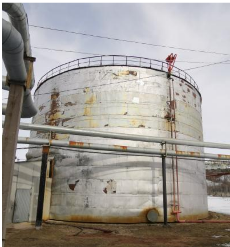
Рисунок 1 – Общий вид резервуаров РВС-3000
