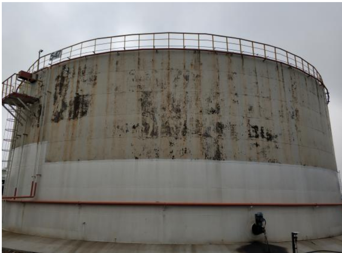
Рисунок 1 – Общий вид резервуара РВС-10000
