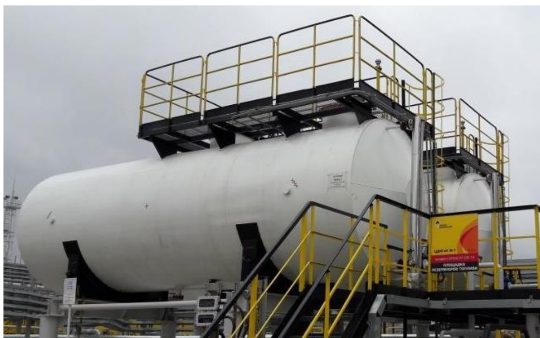
Рисунок 3 – Общий вид резервуара стального горизонтального цилиндрического РГС-50
