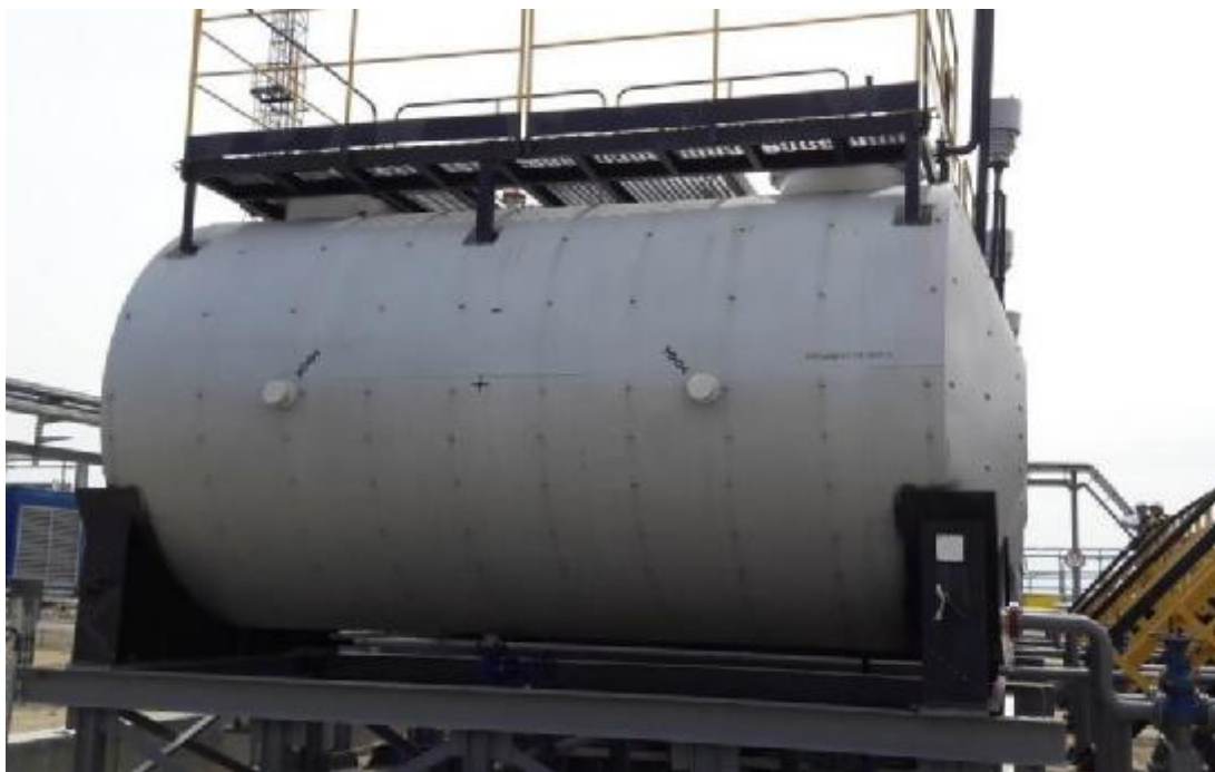
Рисунок 2 – Общий вид резервуара стального горизонтального цилиндрического РГС-25
