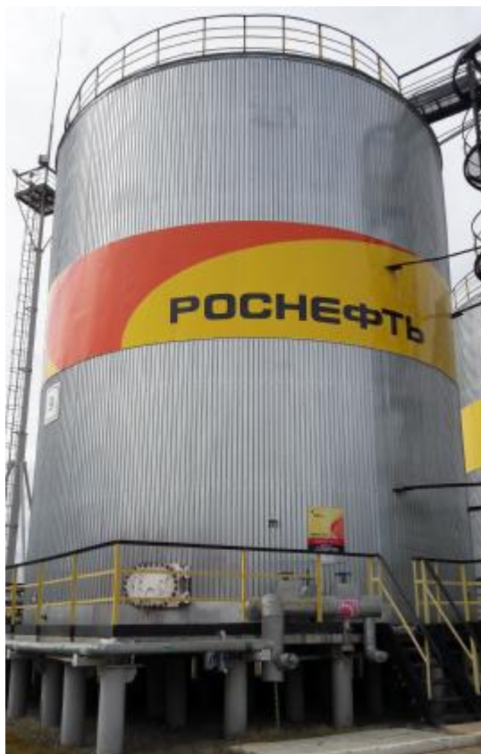
Рисунок 1 – Общий вид резервуара стального вертикального цилиндрического РВС-1000
