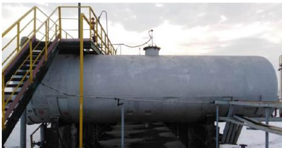
Рисунок 3 – Общий вид резервуаров стальных горизонтальных цилиндрических РГС-60
