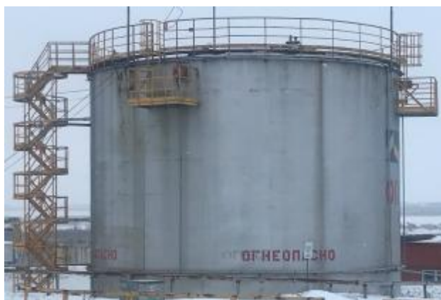
Рисунок 3 – Общий вид резервуаров стальных вертикальных цилиндрических РВС-5000
