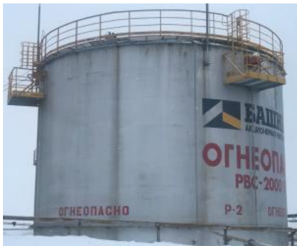
Рисунок 2 – Общий вид резервуаров стальных вертикальных цилиндрических РВС-2000
