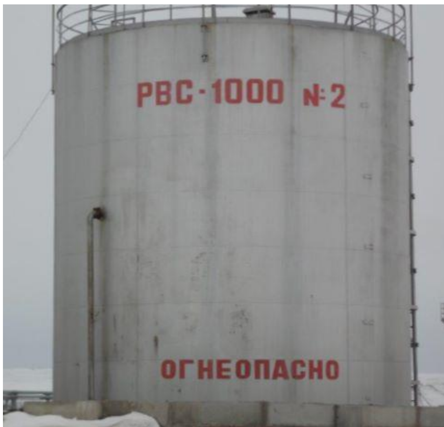
Рисунок 1 – Общий вид резервуаров стальных вертикальных цилиндрических РВС-1000
