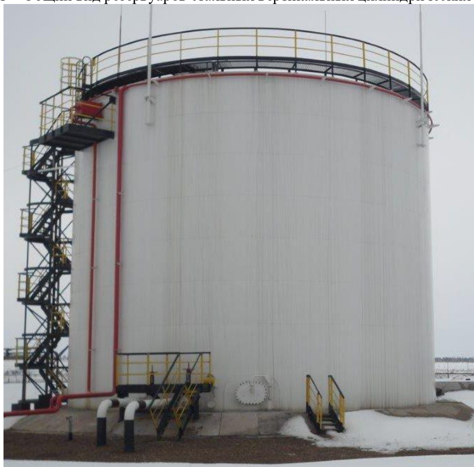
Рисунок 2 – Общий вид резервуаров стальных вертикальных цилиндрических РВС-2000
