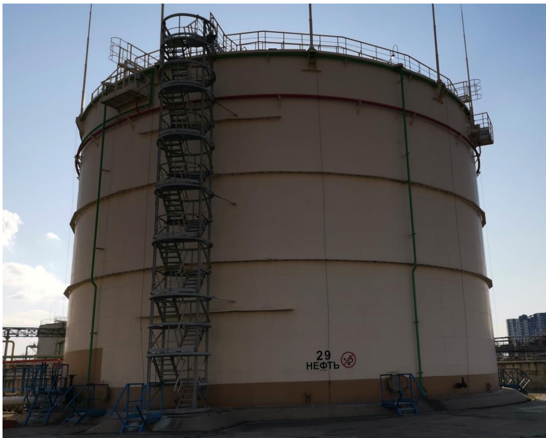
Рисунок 1 – Общий вид резервуара стального вертикального цилиндрического с понтоном РВСП-10000
