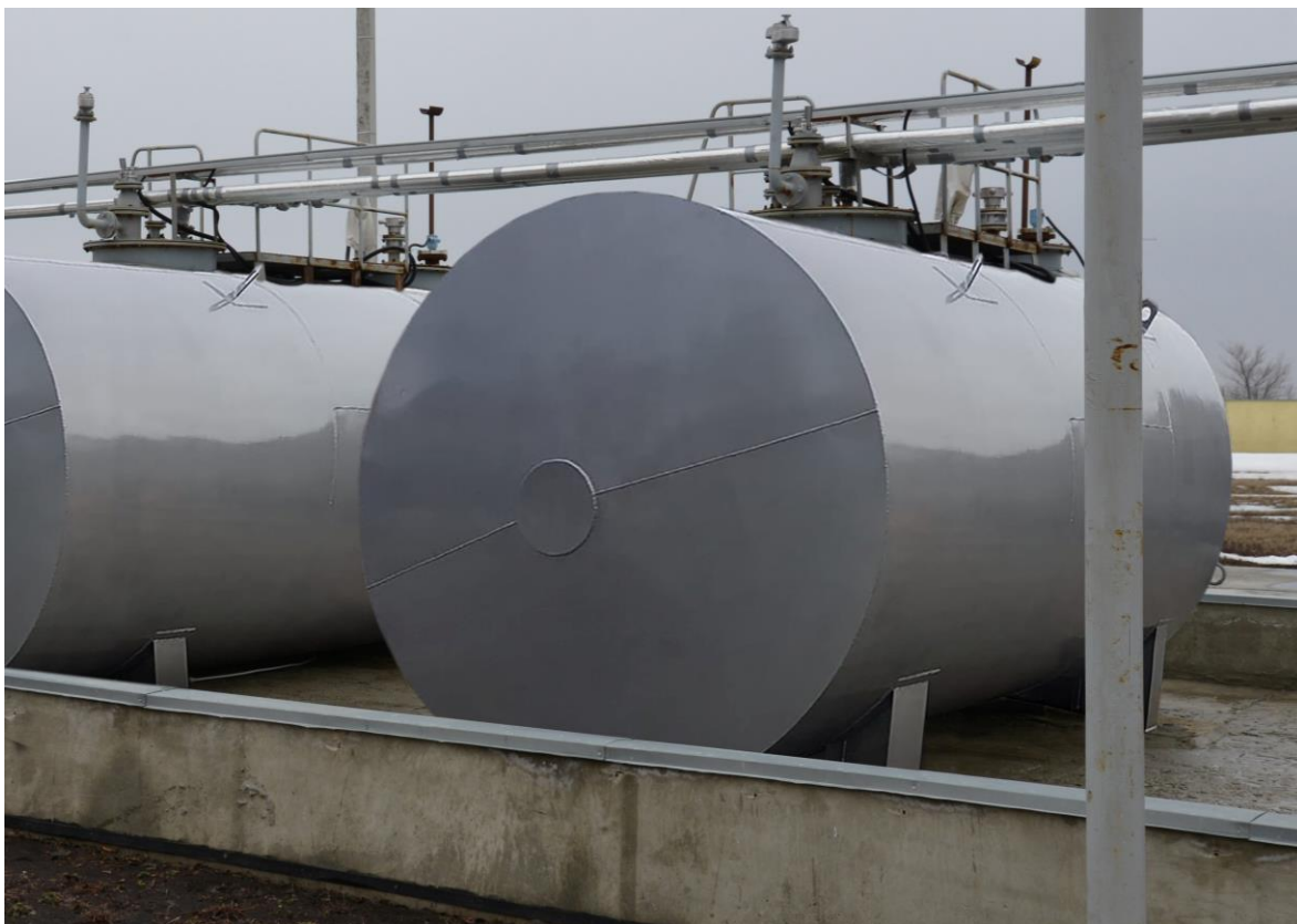
Рисунок 1 – Резервуар горизонтальный стальной РГС-25
