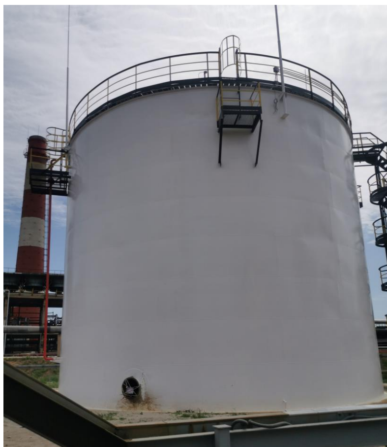
Рисунок 3 – Общий вид резервуара стального вертикального цилиндрического РВС-2000
