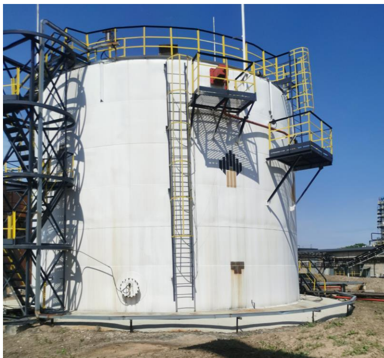
Рисунок 2 – Общий вид резервуара стального вертикального цилиндрического РВСП-1000
