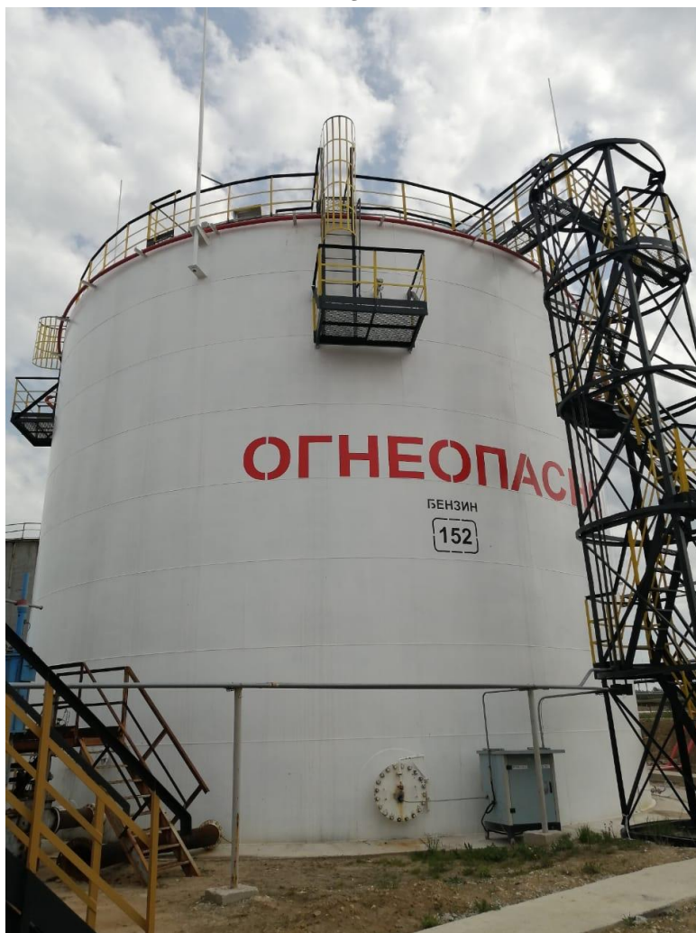
Рисунок 4 – Общий вид резервуаров стальных вертикальных цилиндрических РВСП-2000
