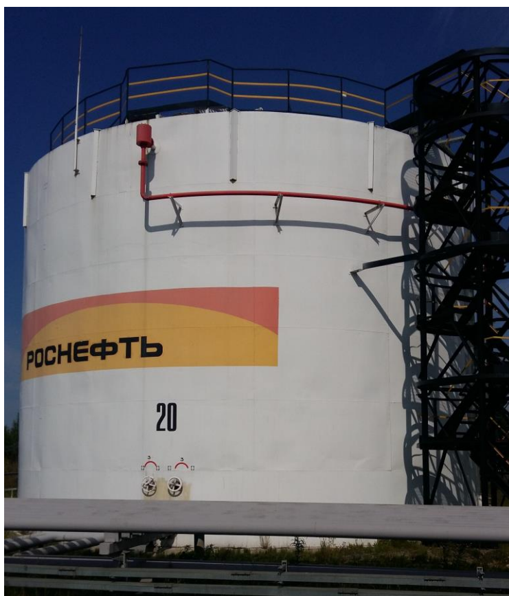
Рисунок 3 – Общий вид резервуара стального вертикального цилиндрического РВС-1000
