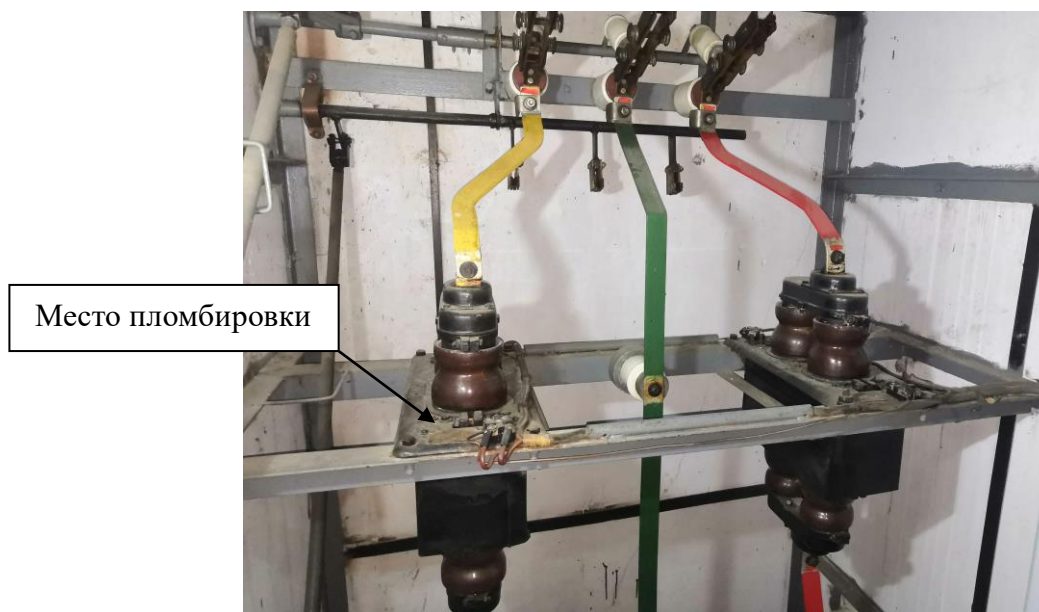
Рисунок 1 – Общий вид средства измерений и схема пломбировки от несанкционированного доступа
