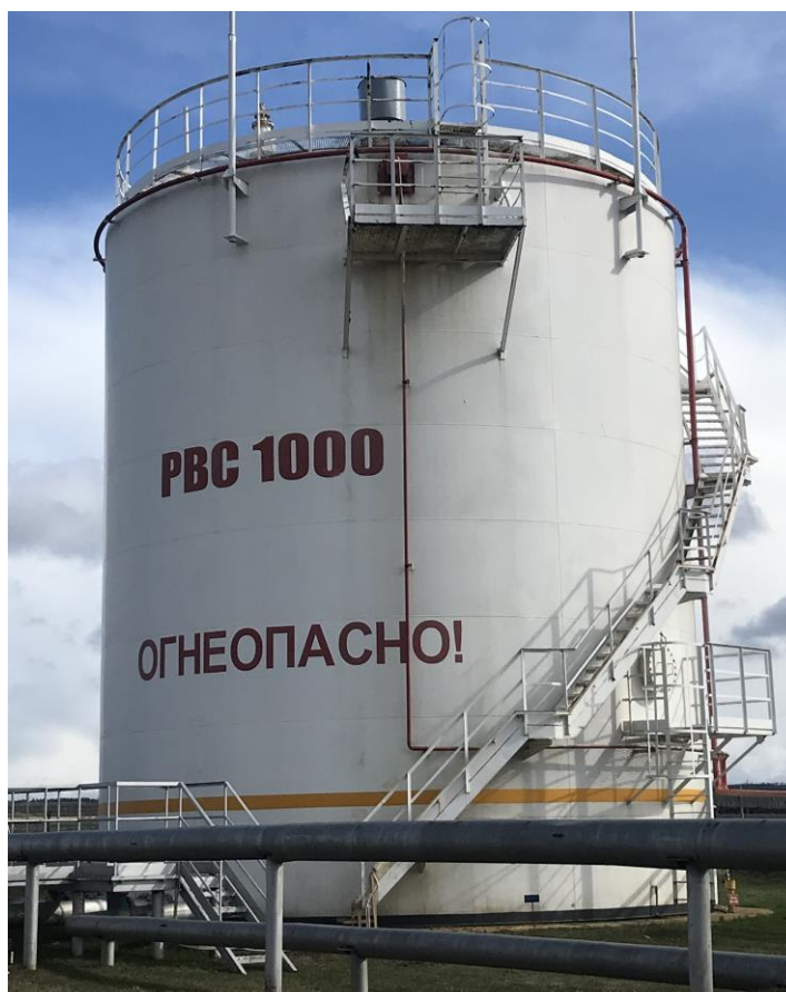
Рисунок 1 – Общий вид резервуара РВС-1000
