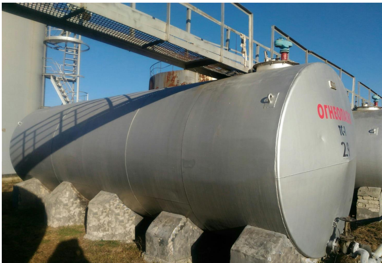
Рисунок 1 – Общий вид резервуаров горизонтальных стальных цилиндрических РГС-50 зав. №№ 123, 130, 892
