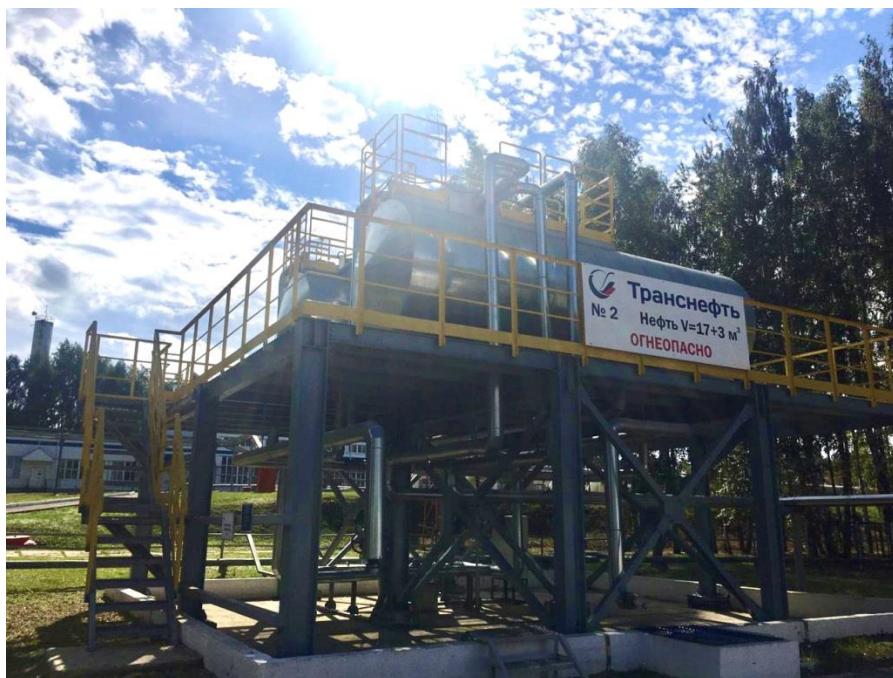
Рисунок 1 – Общий вид резервуаров
