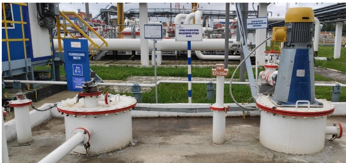
Рисунок 1 – Общий вид резервуаров
