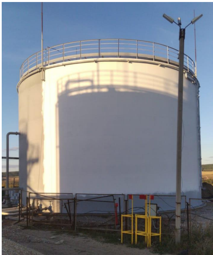
Рисунок 1 - Общий вид резервуара стального вертикального цилиндрического РВС-3000
