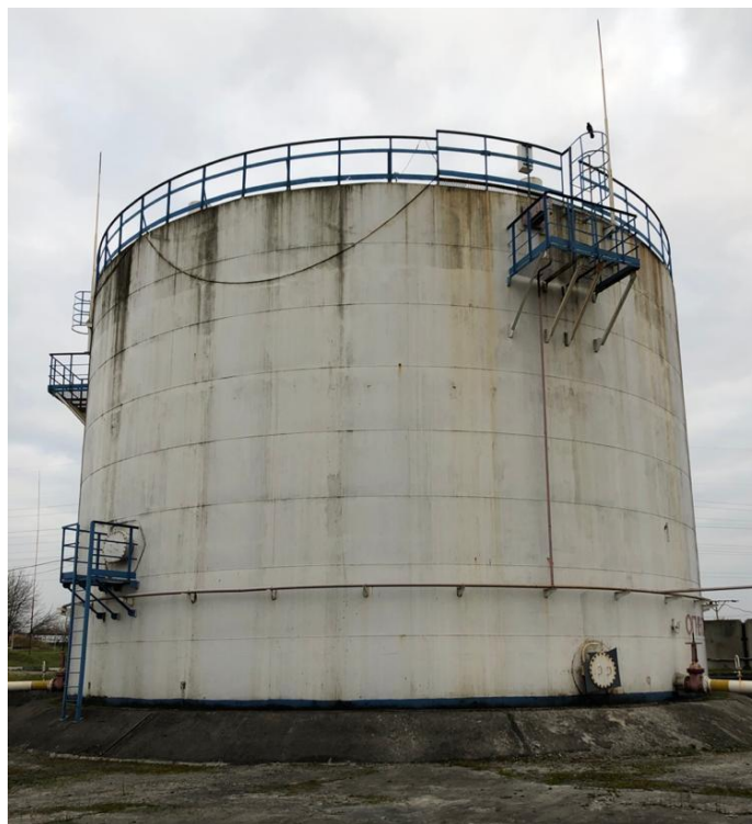
Рисунок 1 – Общий вид резервуаров РВС-2000 зав. №№ 02120, 2020
