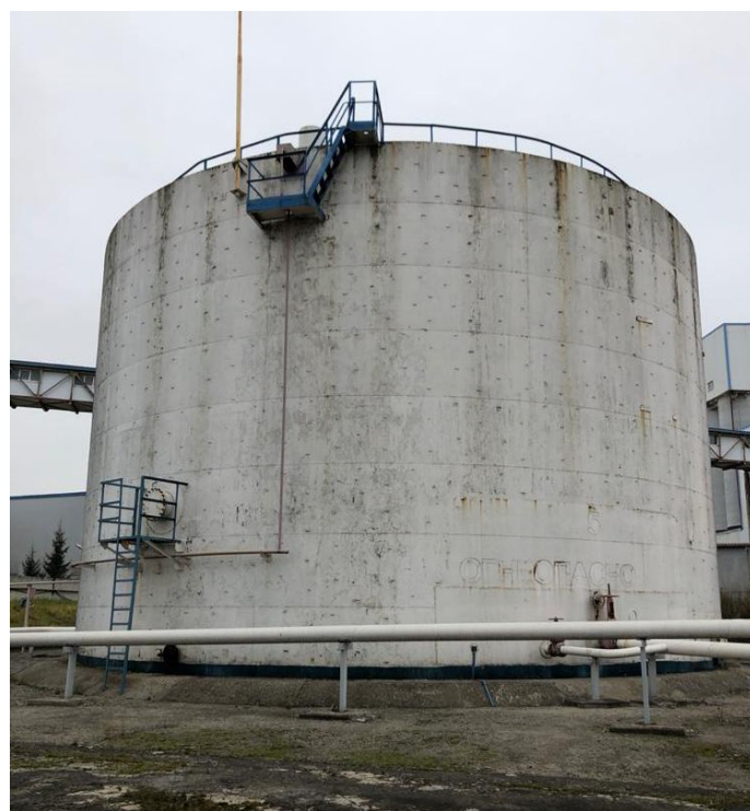
Рисунок 2 – Общий вид резервуаров РВСп-3000 зав. №№ 0313, 0444, 0011
