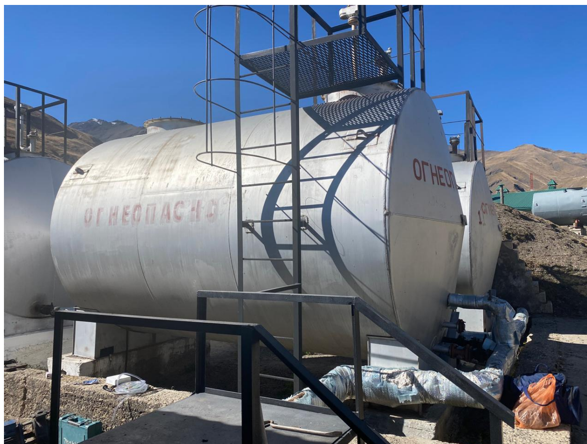
Рисунок 2 – Общий вид резервуаров РГС-25 зав.№№ 7, 9
