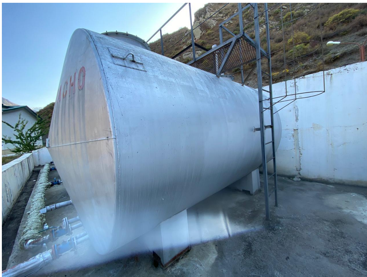
Рисунок 3 – Общий вид резервуаров РГС-25 зав.№№ 5, 6
