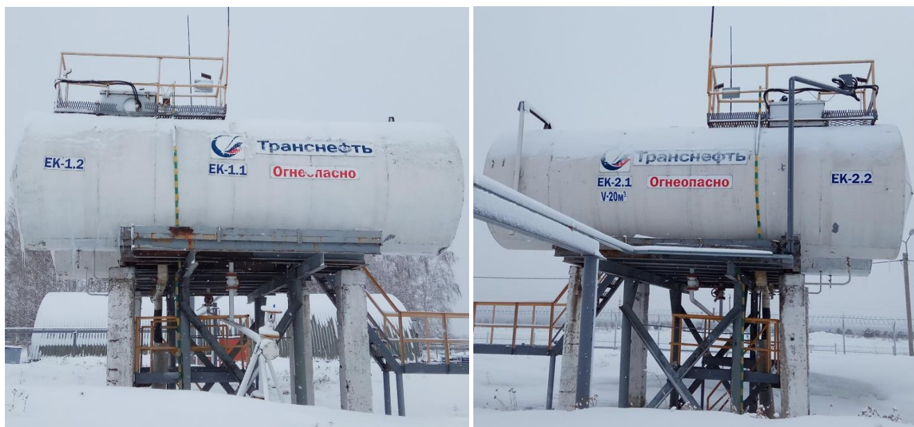
Рисунок 1 – Общий вид резервуаров
