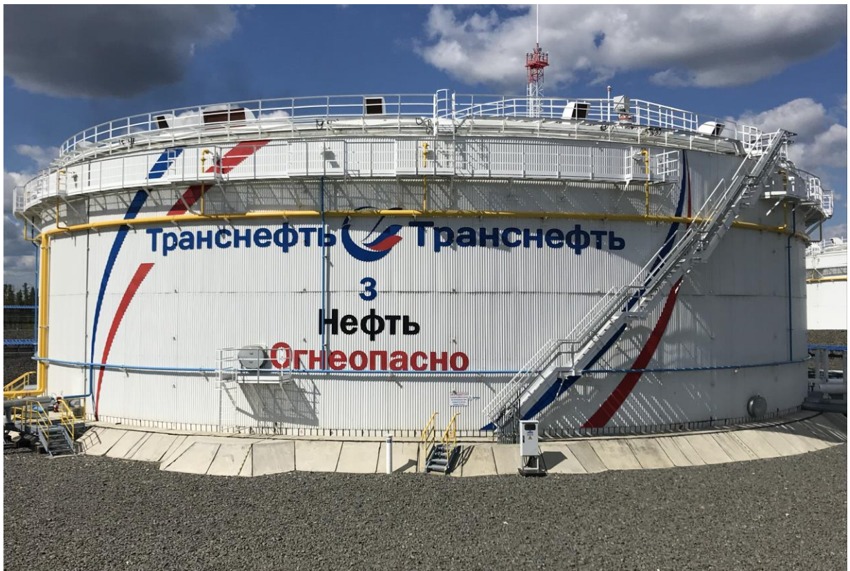
Рисунок 1 – Общий вид резервуара РВСП-20000
